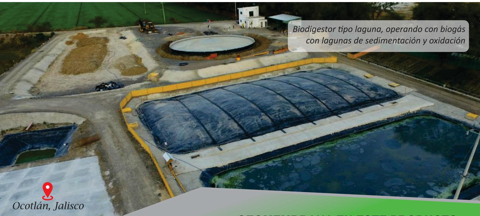
*Biodigestor tipo laguna, operando con biogás con lagunas de sedimentación y oxidación*
